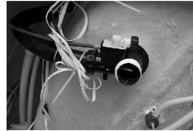
7. Streichen Sie das wasserdichte Gewebedichtungsband glatt.
