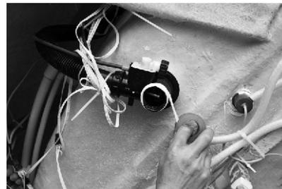
6. Mit dem Gewindedichtungsband umwickeln Sie das Abflussrohr.
