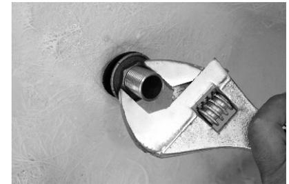
4. Setzen Sie die Dichtung an und befestigen Sie nun von unten mit einem Maulschlüssel die Schraube des Wasserfalls.
