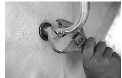
6. Ziehen Sie die Kupplung mit dem Schraubenschlüssel fest.
